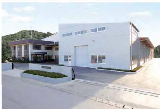
本社・足利工場 (表面硬化熱処理)
